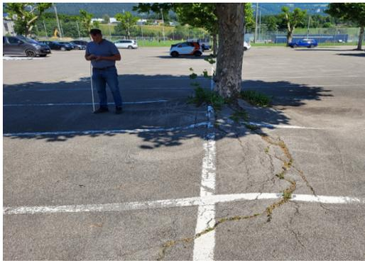
Das Wurzelwerk der mittlerweile alten Platanen reisst den Asphaltbelag an vielen Stellen auf. In anderen Bereichen ist der Belag noch in einem relativ guten Zustand, zumindest die Asphalttschicht.
